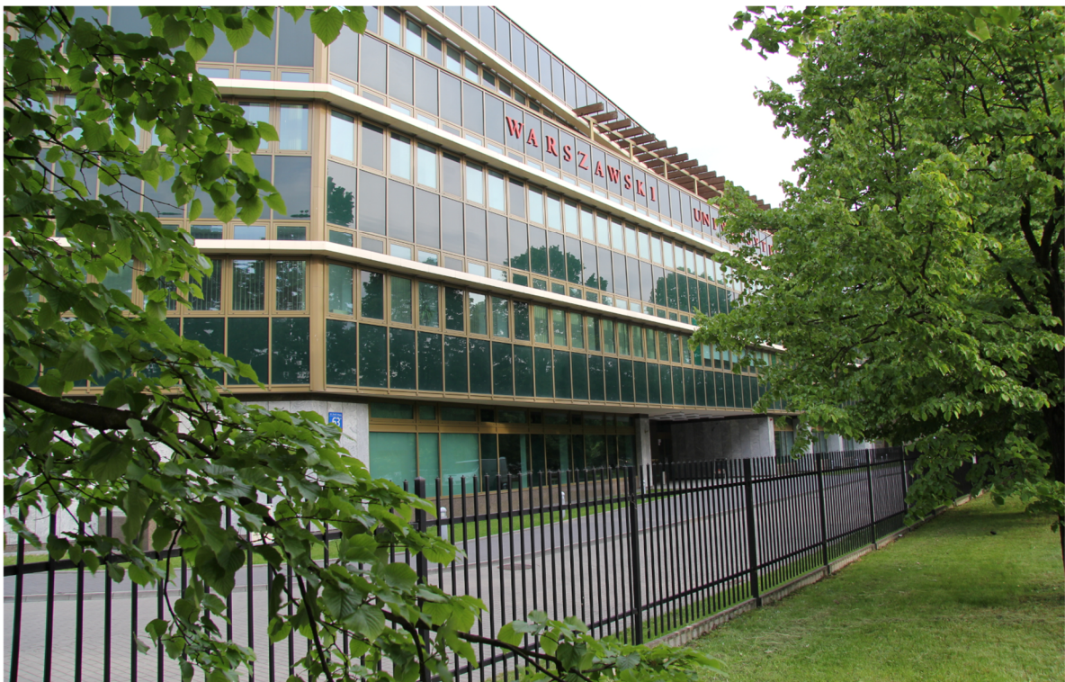
Il. 2. Nowy budynek – Centrum Biblioteczno-Informacyjne
